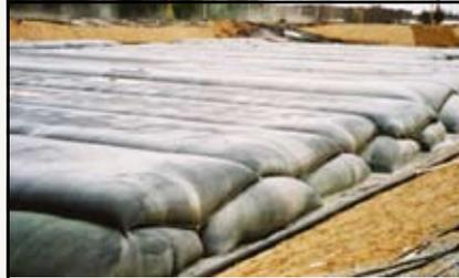
Contenedores Geotube® en una pila de lodos activados en una fábrica de papel.
