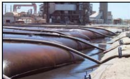
Contenedores Geotube® para desecar cenizas volantes en planta energética de aceite fósil.
