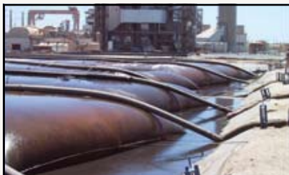
Contentores Geotube® numa central de combustível fóssil usados para filtrar cinzas volantes.
