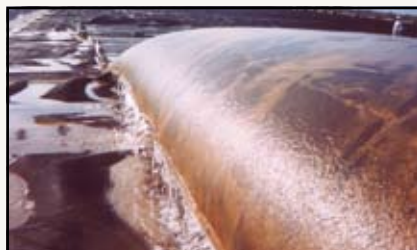
Água escorrendo a partir de um contentor Geotube®.
