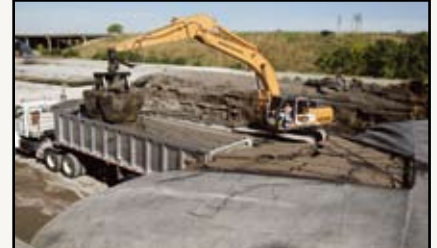
Boues essorées retirées d'une unité GEOTUBE® à l'aide d'un excavateur.
