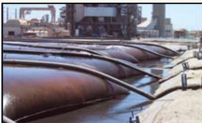
Des unités GEOTUBE® dans une centrale thermique pour le drainage des suies.
