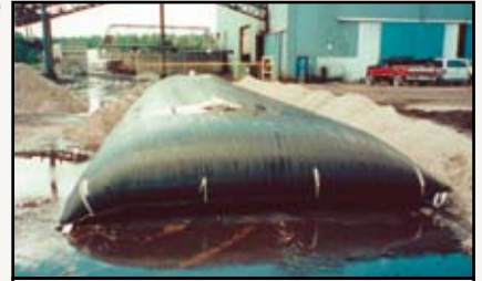
Essorage de déchets de charbon à l'aide de la technologie GEOTUBE®.
