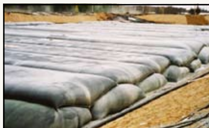
Контейнеры Geotube® на бумажной фабрике
