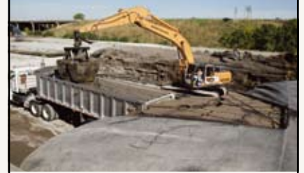
Обезвоженный остаток вычерпывается из контейнера Geotube® экскаватором.
