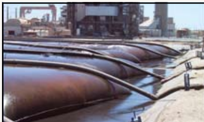
Контейнеры Geotube® на электростанции, работающей на каменном угле, используются для обезвоживания зольной пыли..
