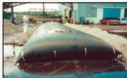
Обезвоживание угольного шлама по технологии Geotube®.
