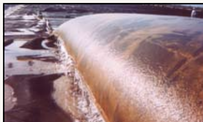
Вода вытекает из контейнера Geotube®.
